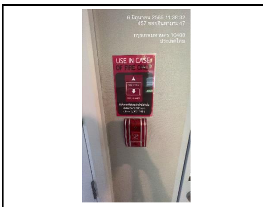
รูปที่ 2-47 อุปกรณ์ส่งสัญญาณเตือน
