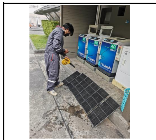
รูปที่ 3.22 ทำความสะอาด เครื่องปรับอากาศ
