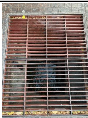
รูปที่ 2-23 ติดตั้งตะแกรงดักมูลฝอย
