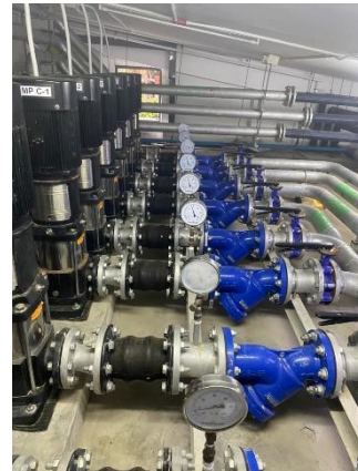
รูปที่ 3.18 transfer pump
