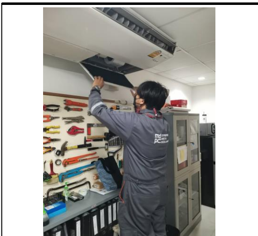
รูปที่ 2-57 ล้างทำความสะอาดแผงกรอง เครื่องปรับอากาศ
