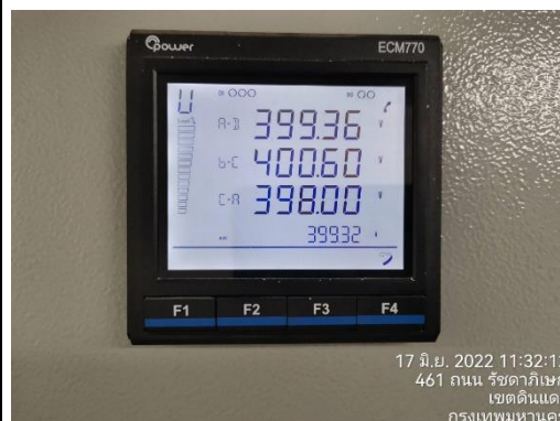
รูปที่ 2-16 ช่างอาคารตรวจสอบระบบ ไฟฟ้า MDB
