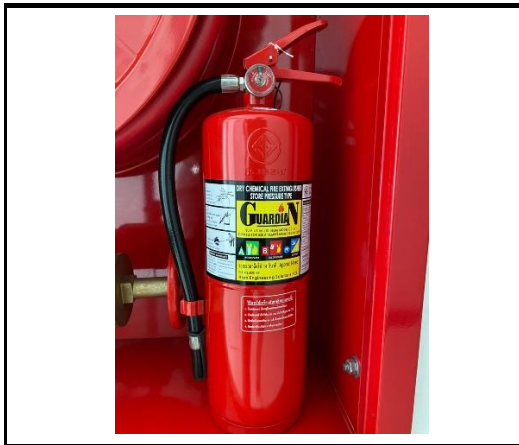
รูปที่ 2-43 ถังดับเพลิงเคมี
