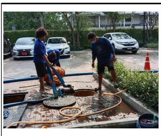
รูปที่ 3.11 พนักงานเข้าตรวจสอบตะกอน
